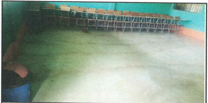
Foto 4: COLOCACIÓN DE PISO CERAMICO ANTIDESLIZANTE PARA TENER UN MAYOR CONFORT EN LA ESCUELA.
