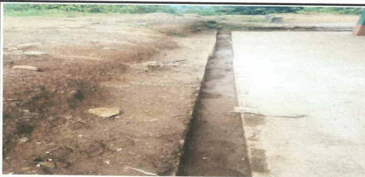
Foto 1: AMPLIACION DE CUNETAS DE CONCRETO YA QUE CORRE MUCHA AGUA POR EL AREA Y SE SALE DEL CANAL DE CONCRETO
