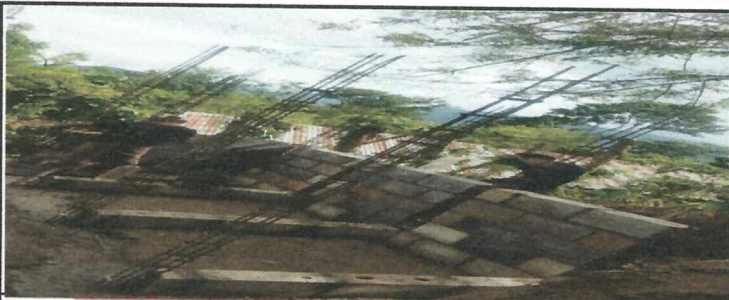
Foto 5: AREA A COLOCAR LA REHABILITACION DE BAÑOS
